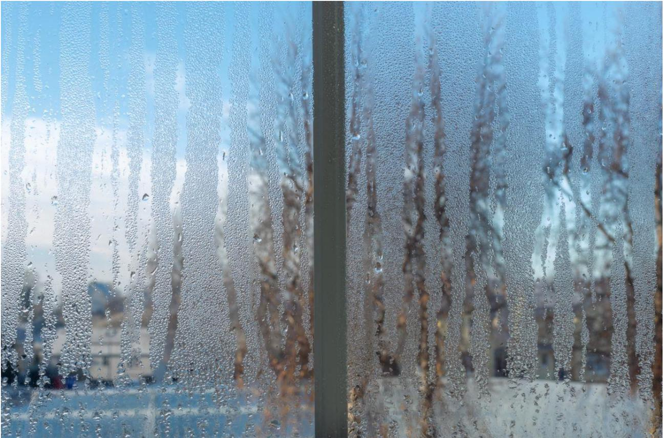
Oltre al “trucco” dell'accendino, ci sono altri dettagli a cui fare attenzione per verificare la tenuta delle finestre nei mesi invernali, come ad esempio controllare la condensa sulla superficie interna dei vetri
