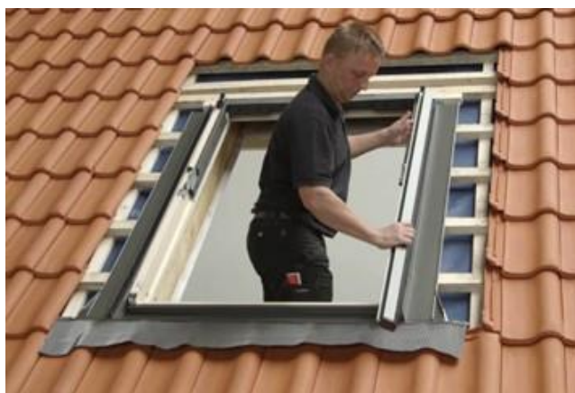
Realizzazione di una nuova apertura in copertura.
