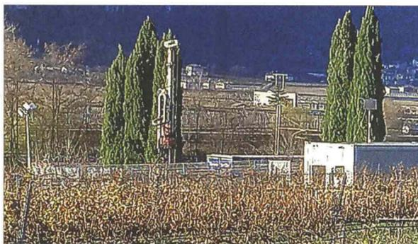
La trivella installata da qualche giorno a Mattarello per eseguire i sondaggi fino a 40 metri di profondità lungo il tracciato della circonvallazione ferroviaria
