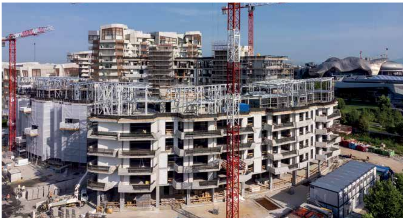
Cantiere Residenze Libeskind II (Credits Alberto Fanelli)
