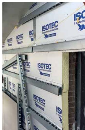
portanti e abbinati a qualsiasi rivestimento di copertura o di facciata. La ventilazione naturale che si attiva dietro il rivestimento di facciata o sotto il manto di copertura è funzionale al rapido smaltimento dell'umidità in inverno e del calore superficiale in estate, per un ambiente abitativo salubre e confortevole in tutte le stagioni dell'anno.
