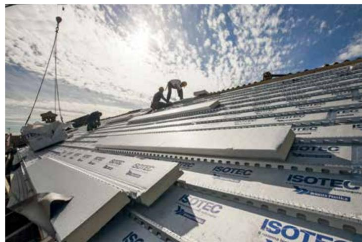
Isotec, isolamento ventilato per la riqualificazione energetica dell'involucro
