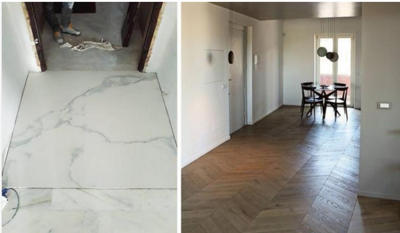
A sinistra: risultato ottenuto dalla sovrapposizione su pavimento esistente di rivestimento in gres. A destra: risultato ottenuto dalla sovrapposizione su pavimento esistente di parquet a spina di pesce.
